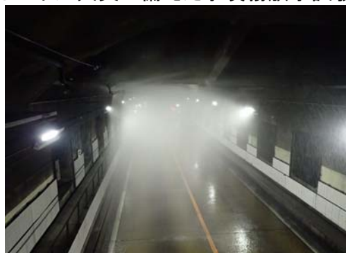
【道路施設点検状況】
