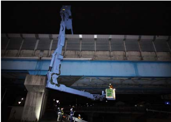
【橋梁詳細点検】
