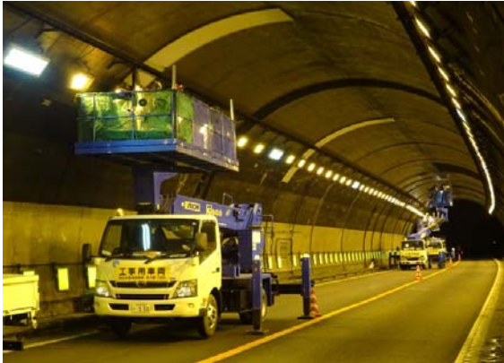
【TNはく落対策(目地部樋設置)】
