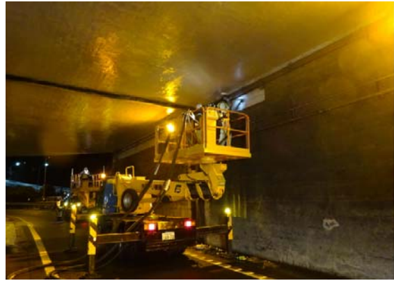
【C-BOXはく落対策】
