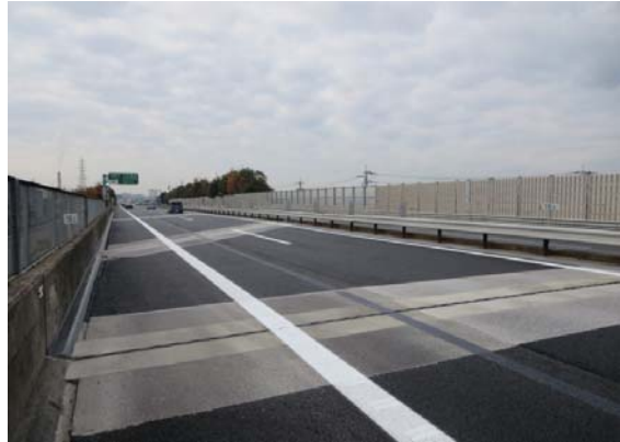
【伸縮装置取替工】
