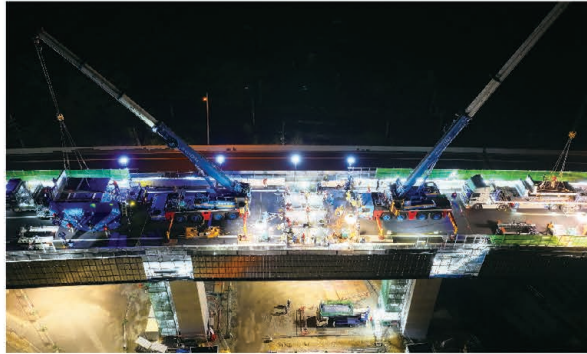
床版取替状況(境谷橋)
