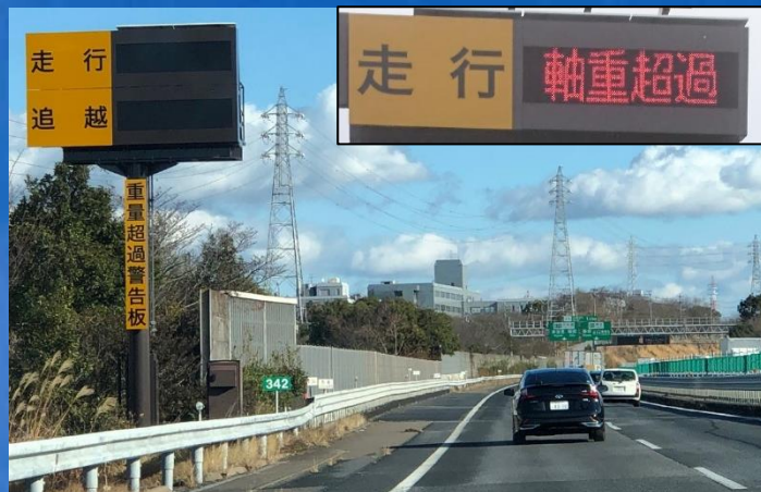
高速道路本線での「軸重超過」表示
